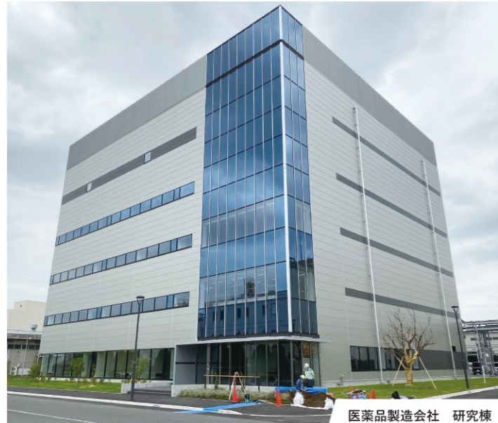
医薬品製造会社 研究棟
